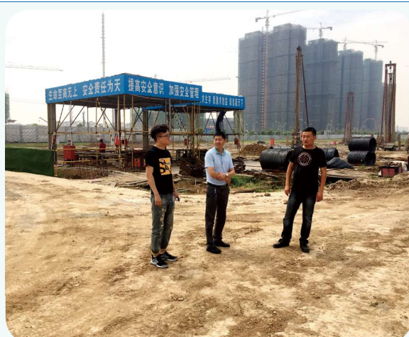
胜海湖纤维谷项目现场监督检查
